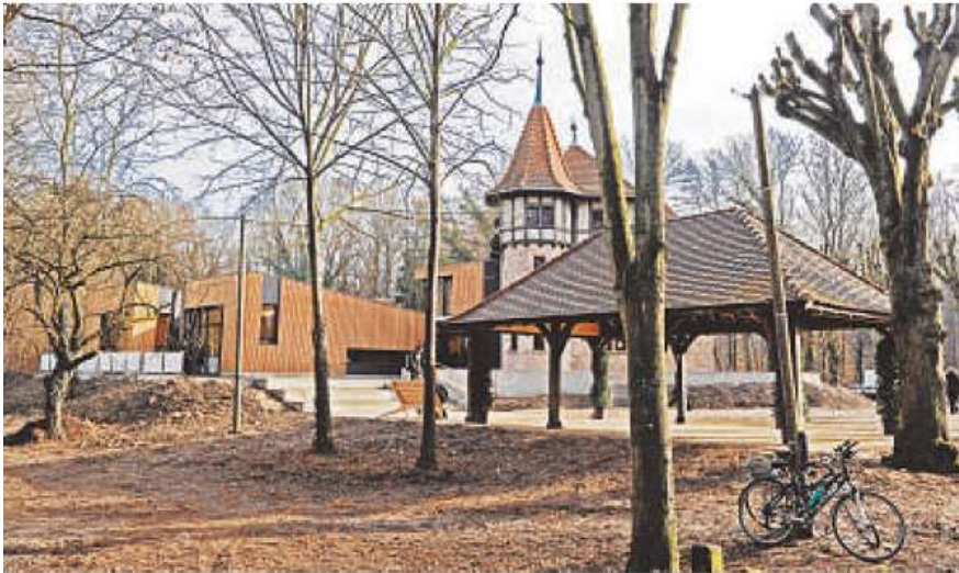
Environ 700 mètres dévolus à l'apprentissage de la nature, en pleine forêt du Neuland: l'extension en bois prolonge le bâtiment d'origine qui a conservé son cachet d'antan.
