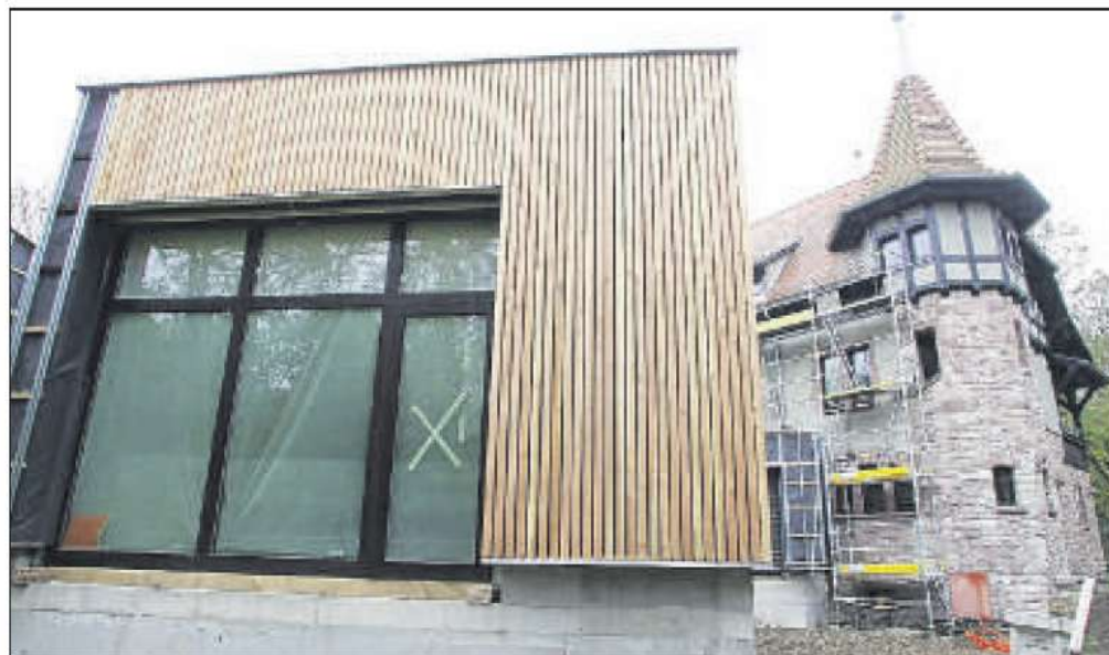
Au premier plan, une partie de la nouvelle annexe en ossature bois, qui prendra la teinte des arbres alentours. Au fond, l'ancienne Auberge du Neuland, nettoyée et rénovée en gris kaki, dans l'esprit originel. Une autre extension est encore envisageable. Photos Hervé Kielwasser
