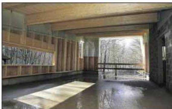
L'extension neuve a une ossature et une charpente en bois. La toiture végétalisée sera recouverte de graminées et de plantes de rocailles.
