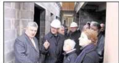
La visite de chantier a été guidée, hier matin, par l'architecte Mathieu Laperrière. Photo C.C.
