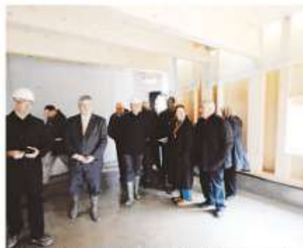
Mathieu Laperrelle (à gauche) informe les visiteurs sur l'avancée des travaux.
